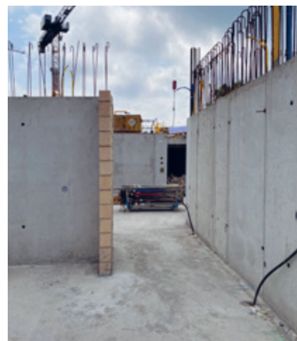
Wände im 1. Stock, bereit für die Schalung der Decke
