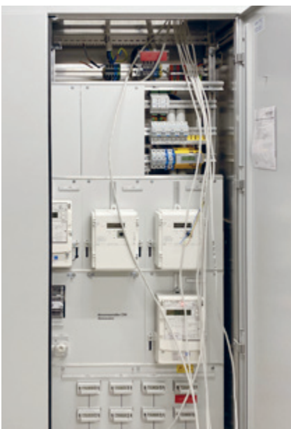
Elektroverteilkasten
