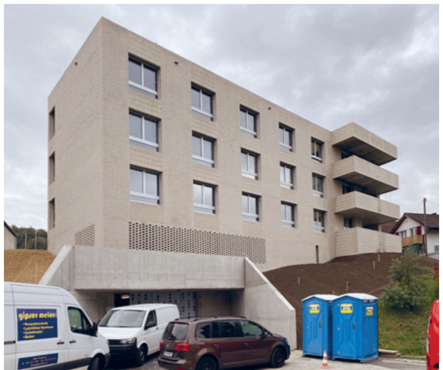
Ansicht von Norden mit der Einfahrt in die Tiefgarage
