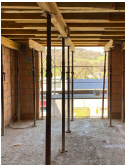
Hier entsteht ein schönes Einerzimmer
