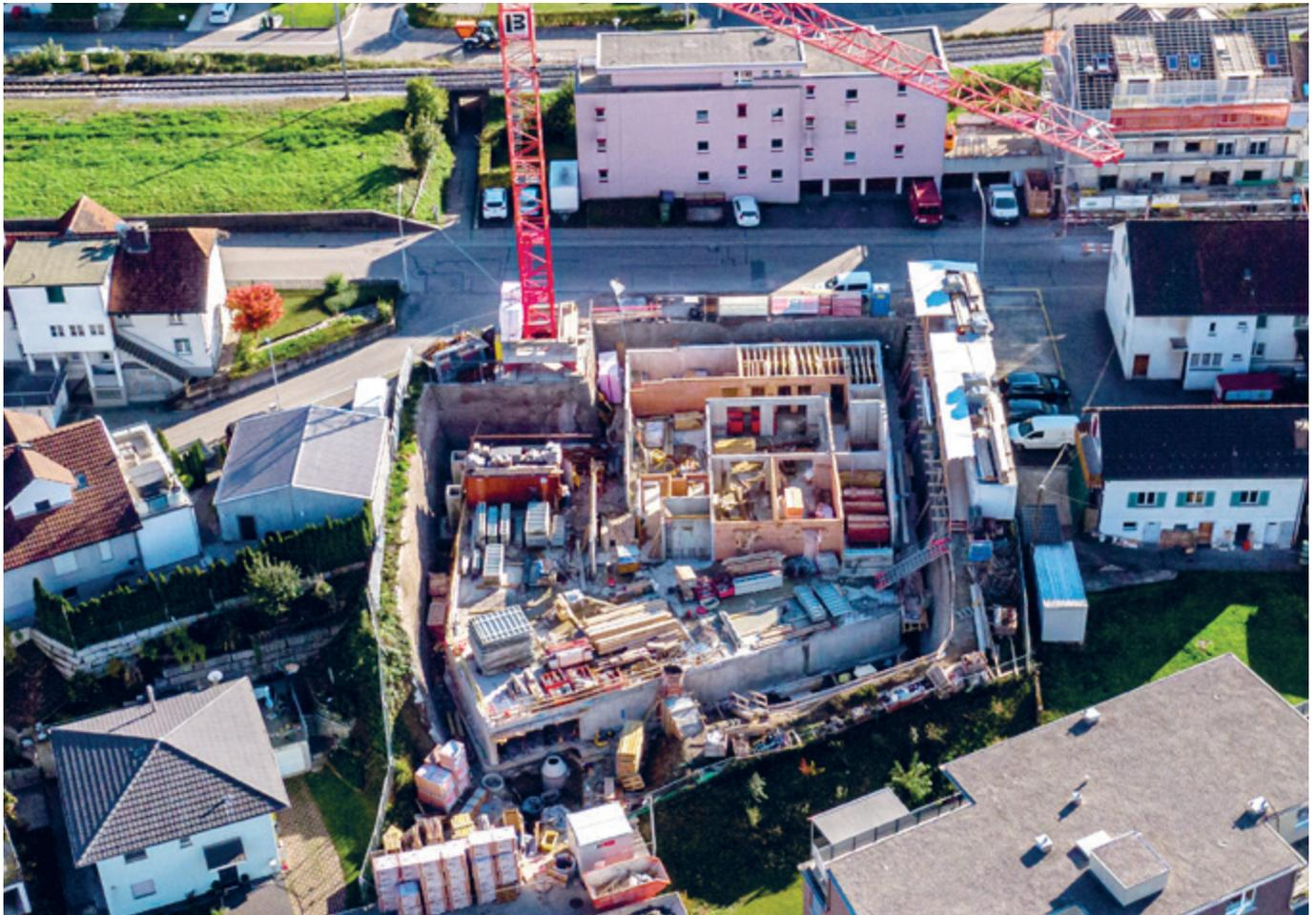
**Almacasa Pfungen, Bauzustand 13. Oktober 2020 mit Tiefgarage (Beton) und Untergeschoss (Backstein)**
