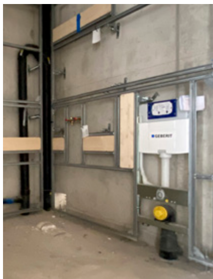
Vorwandinstallation für ein WC in einem Badezimmer
