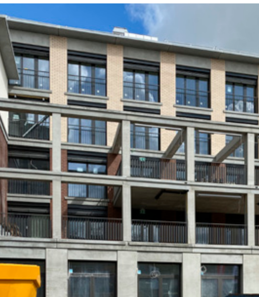
Ausgerüsteter Teil der Überbauung
