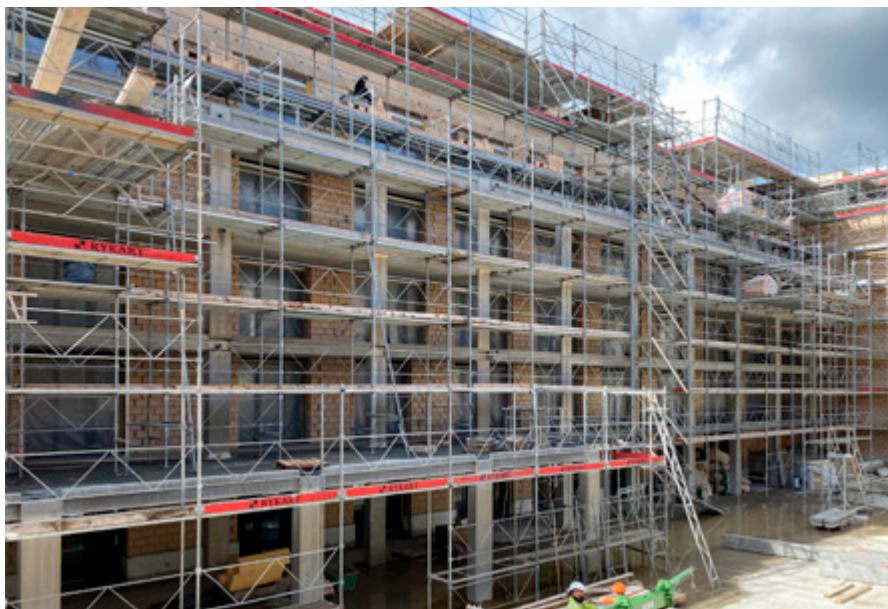
Noch eingerüstet, die Fassade des Almacasa zum Innenhof
